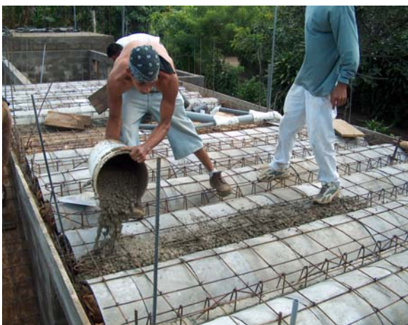
Start to pour the concrete.....
