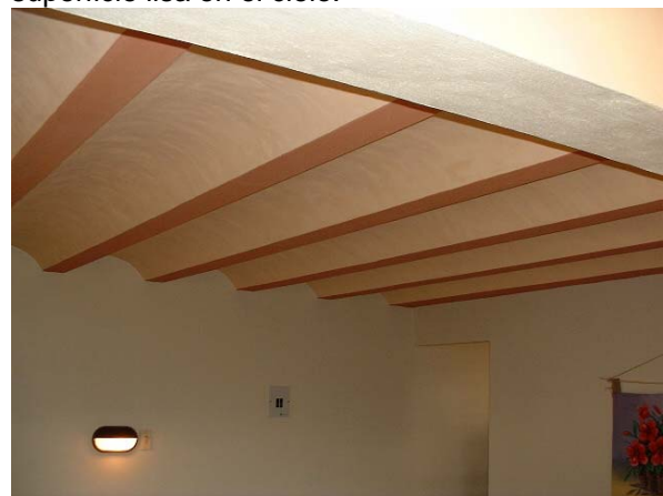
Vista desde adentro con las bóvedillas pintadas
