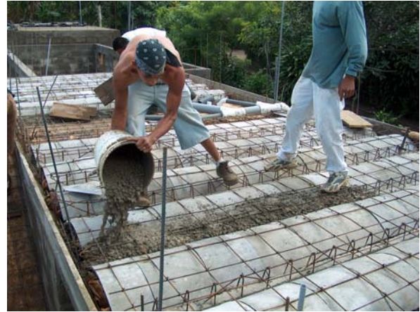
Empezar a verter el concreto
