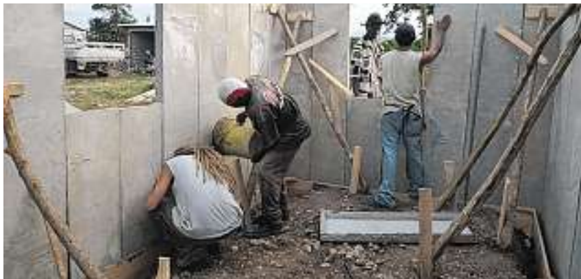
21. Dezember: Das erste Haus aus Kernelementen nimmt Formen an, wie das von der Baustelle aus Haiti gemailte Bild zeigt.
