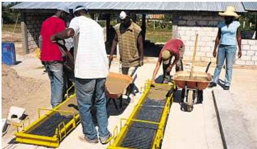
Endlich: In Liancourt werden Ende November die ersten Betonelemente mit der richtigen Maschine produziert.
