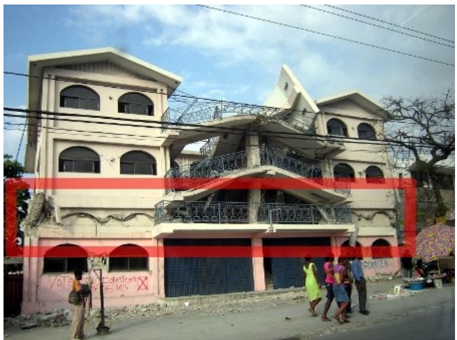
En el recuadro rojo, la segunda planta desapareció debido al fallo de las columnas
