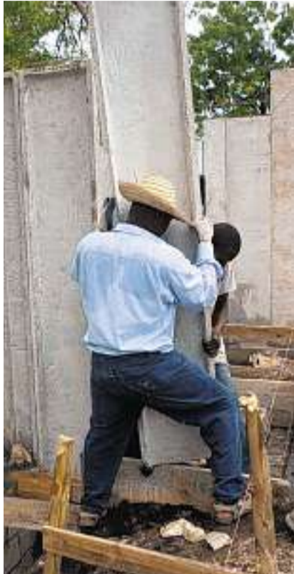
Gemeinsam geht es am besten: Zwei Bauarbeiter verankern Wandplatten.
