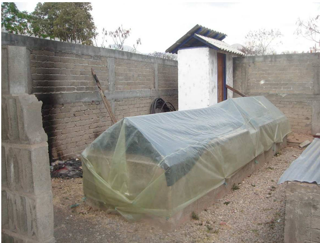
Tanque cubierto para curado a vapor. Al fondo: Sanitario seco.
