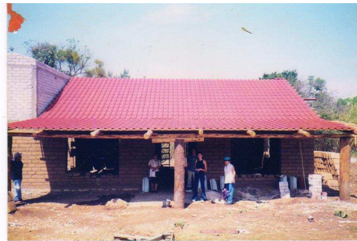
Esta casa se cubrió con nuestro primer pedido grande de teja, el cliente la pintó con impermeabilizante rojo.
