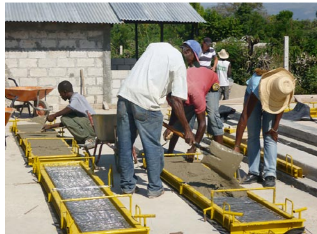
Ferrozement-Platten werden manuell hergestellt
