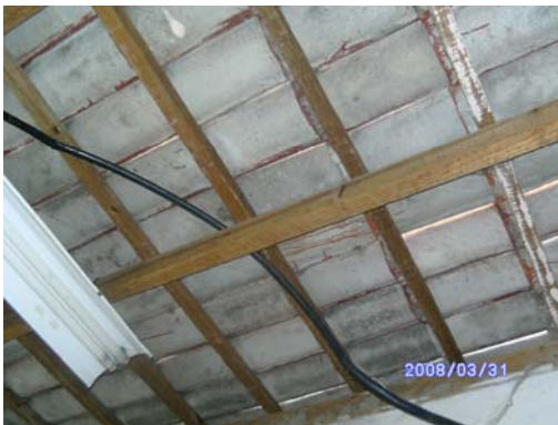
Vista de la estructura de techo de TMC.
