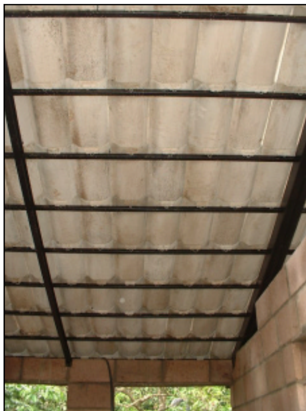
Un buen montaje de techo sobre estructuras metálicas.
