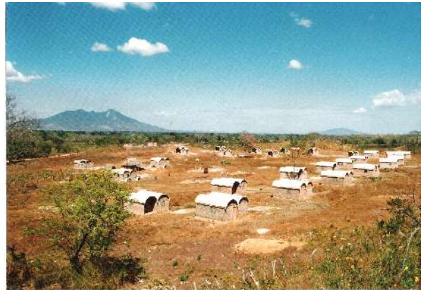
Die Baustelle auf dem neuen Grundstück
